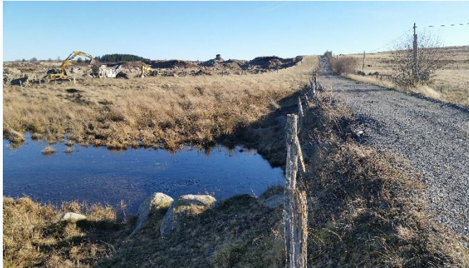
Chemin d'accès, vue vers la carrière
